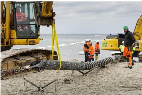
Horns Rev 3.海底ケーブル 220 kV の敷設作業ケーブルの直径は 28 cm 重量 94 kg/m, ケーブルドラム 1 個当たり 1500m、全部で 90 個、計 135 km の敷設作業 2016 年 6 月末終了。
